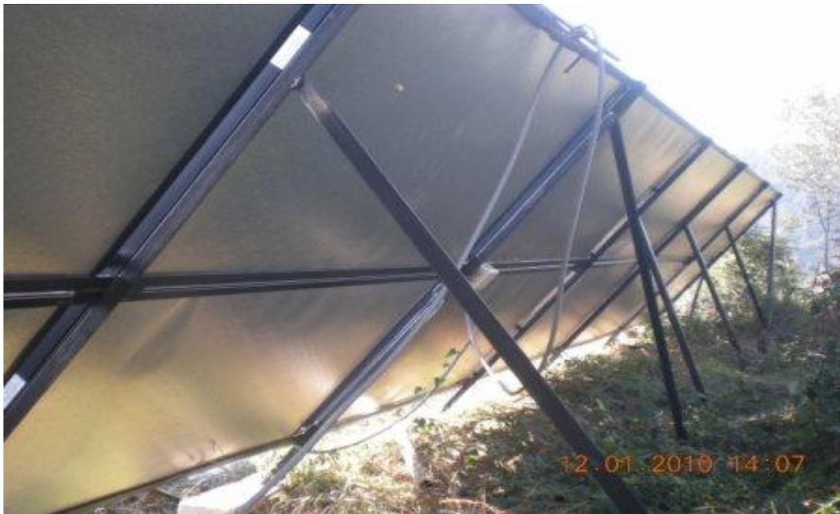
*Vue de derrière des capteurs. La structure est réalisée en cornière de 40 x 40, l'inclinaison est telle qu'à midi au 15 février le soleil est perpendiculaire (c'est le moment le plus froid de l'année en général). L'idéal serait d'avoir une structure inclinable avec par ex. 5 ou 6 positions. J'y réfléchis...*
