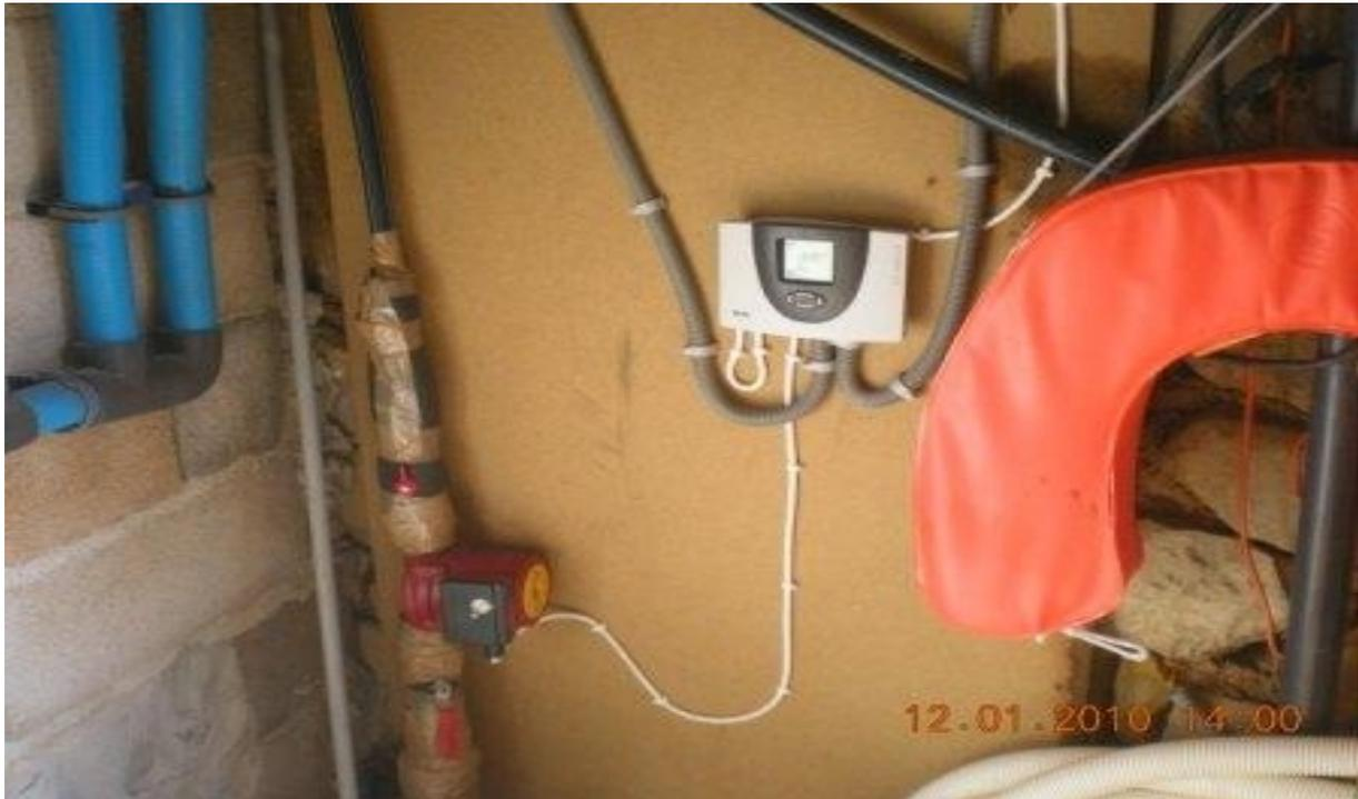
*La paroi en parpaings à gauche est celle du bac-tampon. Le circulateur doit être placé sous le niveau d'eau. Une vanne en amont, une en aval : on ne sait jamais . . .*
