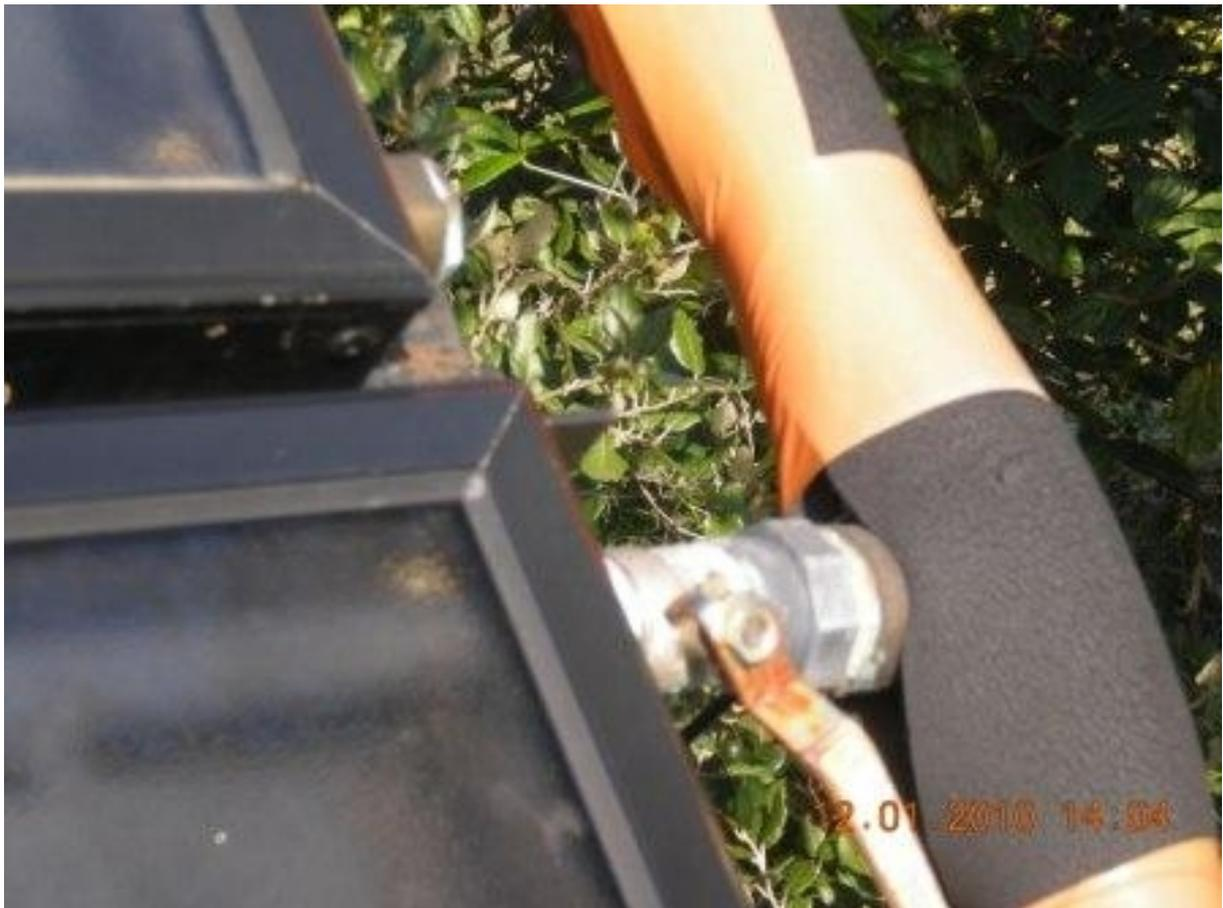
*Une vanne est installée en sortie haute de la rangée du bas, pour forcer l'eau à monter dans la rangée du haut.*
