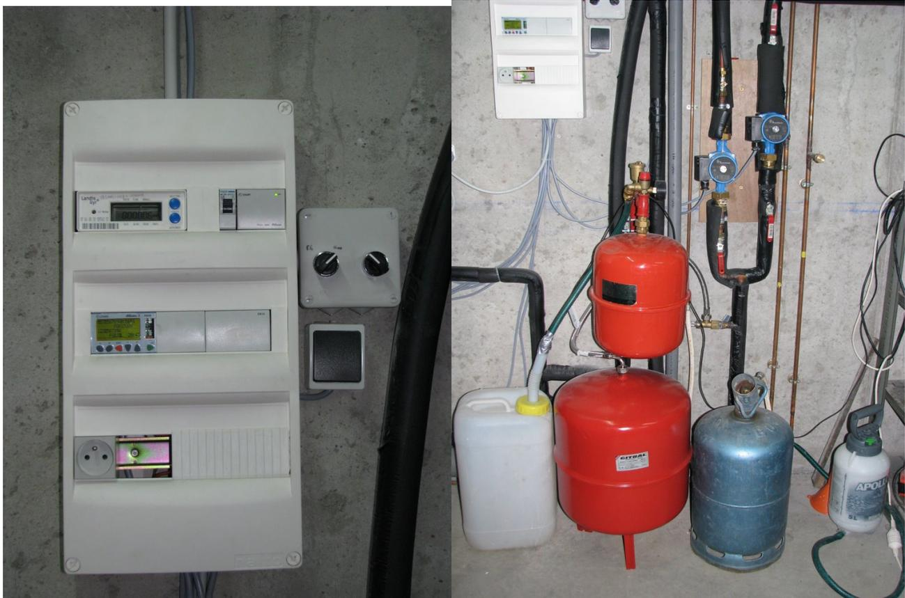
Le remplissage se fait avec du liquide de refroidissement automobile en monopropylène glycol.
