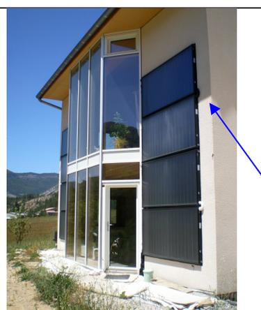
Le 21 juin, l'ombre de l'avancée de toiture couvre les panneaux les plus hauts. Aucune importance dans le bilan car 100% des besoins sont largement couverts de toute façon à cette époque.
