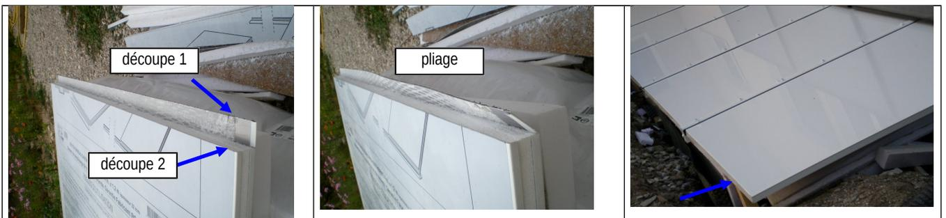
*Pliage des extrémités de panneau sandwich pour réalisation goutte d'eau*
