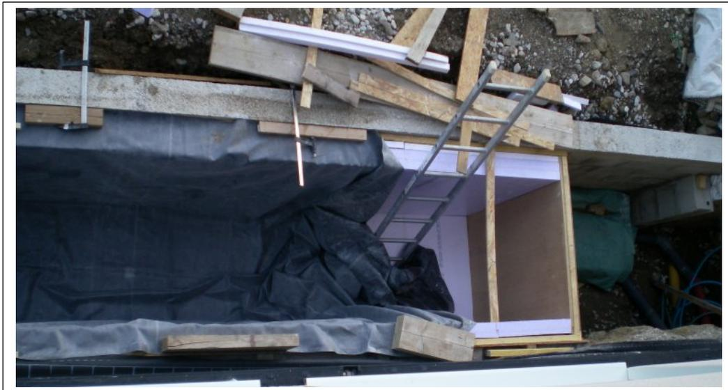
Il est important que la partie supérieure soit de niveau. J'ai utilisé un tuyau transparent rempli d'eau pour faire un repérage précis sur toute la périphérie. Le but est de pouvoir remplir le stock au maximum, c'est à dire juste en dessous des tuyaux d'arrivées capteurs. Compte tenu de la surface de la cuve, le niveau est à peine modifié ( $< 1\text{cm}$ ) lors du remplissage de tous les capteurs.
