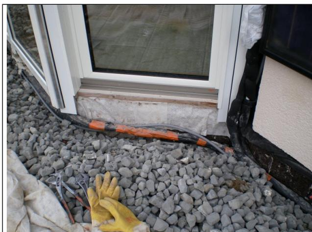
Les tubes PER de liaison entre panneaux et stockage sont noyés dans le granulats de verre cellulaire (Technopor) qui a été répandu dans les tranchées verticales pour isoler la dalle de l'extérieur.
