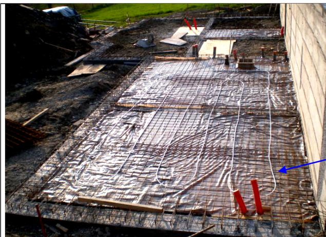
Les émetteurs de chauffage d'appoint se résument aux planchers chauffants du rez de chaussée, soit une nappe de PER multicouche de diamètre DN16 de 50m de long coté pro (celle que l'on voit sur l'image) et une autre nappe identique coté logement (non encore posée ici).
