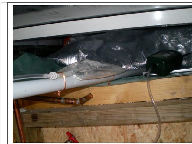
On distingue ici la poche plastique et le tube (PVC diam 4mm), de même que la pompe initialement utilisée (abandonnée car interdisant le dégonflage). Le tube va être mis en place dans la cuve, sous l'isolant et le polyane vert (remplacé depuis par un PVC)
