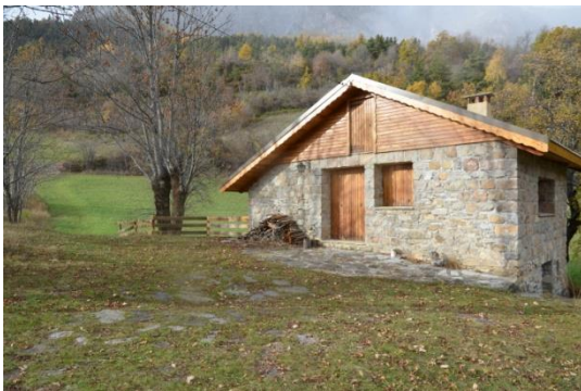
Niveau 1, façade sud
