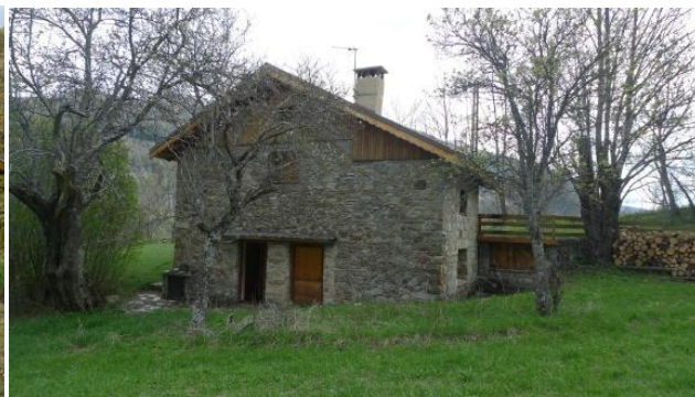
Niveau 0, façade nord, enterrée au sud
