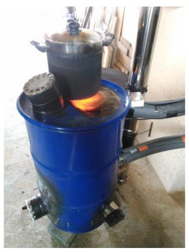
Nous l'avons d'abord raccordé en thermosiphon, mais cela n'a pas fonctionné en raison de la configuration locale. Nous avons donc installé une vanne 3 voies et une pompe de circulation sur le retour. Cette vanne oriente le liquide caloporteur vers le rocket stove plutôt que vers les capteurs solaires parce dans notre configuration, le rocket stove et les capteurs solaires se partagent un même cumulus.
