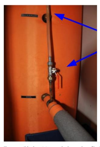
Il est possible de cuisiner sur le dessus du poêle. Nous avons effectué plusieurs chauffes. La montée en température s'effectue lentementt. Les 400 litres d'eau du cumulus solaire sont élevés d'environ 10°C avec une chauffe d'environ 2H.
