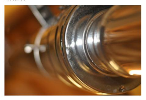
Le conduit est partagé entre deux rockets stoves, le Poelito lui fonctionne l'hiver, dispose d'inertie, chauffe la pièce et produit de l'eau chaude, le rocket Couscoulito qui fonctionne le reste du temps et permet essentiellement de cuisiner.
