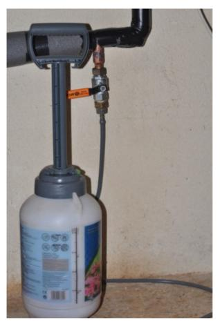
Le pulvérisateur permet d'injecter le liquide caloporteur depuis le bas du circuit et de diriger ainsi les bulles vers le purgeur automatique qui est situé en partie haute du circuit, juste à l'entrée du cumulus solaire :
