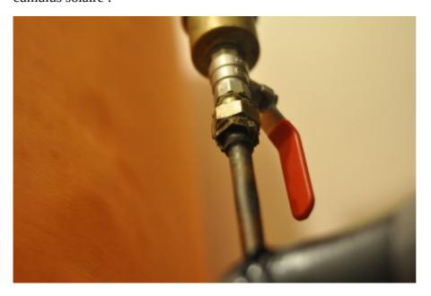
A la place du purgeur automatique, il est possible d'installer une petite durite transparente juste le temps de vérifier le niveau du liquide caloporteur :
