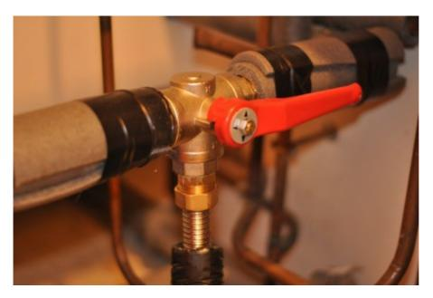
Le circuit primaire est réalisé pour partie avec du cuivre et pour le reste avec d'inox annelé (en raison d'une zone où le passage de tuyaux de cuivre aurait été difficile. Nous avons testé <u>la procédure de mise en œuvre de l'inox annelé sans outil spécifique diffusée sur le site APPER.</u> :
