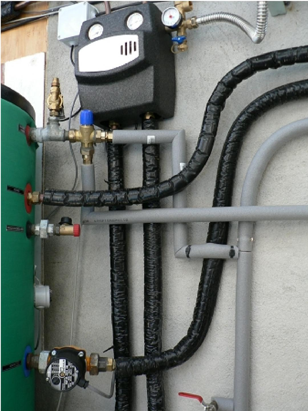
Raccordement ballon de stockage via le groupe de transfert aux capteurs.
