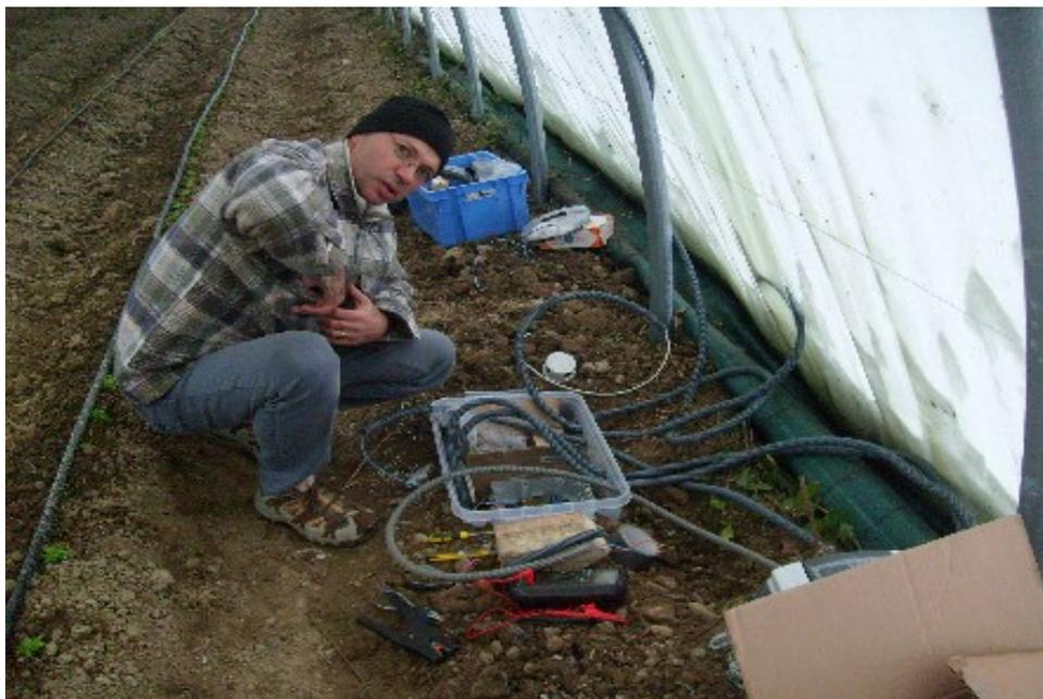
Ce dimanche, neige forte;  $-1^{\circ}\text{C}$  ds les capteurs, nous décidons de réchauffer un peu les capteurs avec la terre pour vérifier le bon fonctionnement du drain back.
