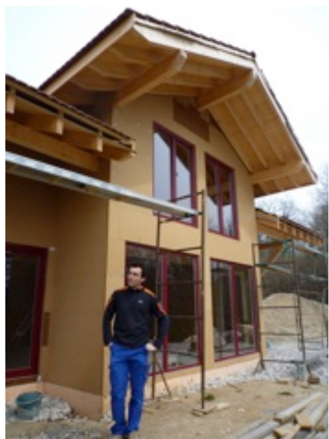
Double Flux et solaire Atmos, construction poteaux poutres, isolation laine de bois Maison basse consommation
