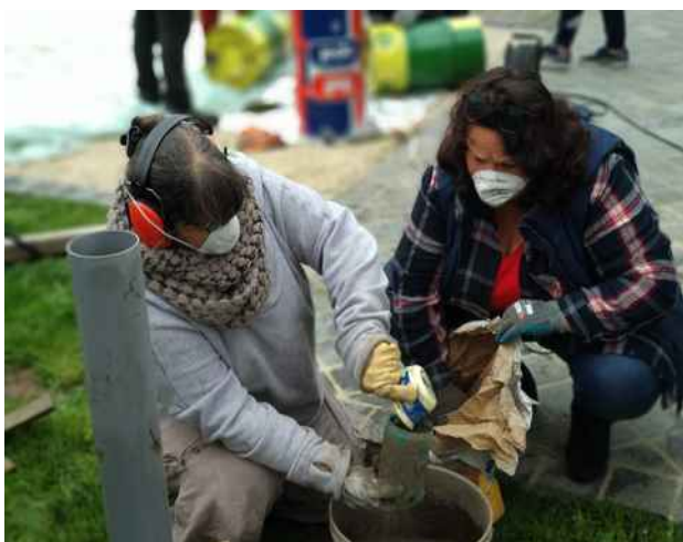
Mélange du béton réfractaire
