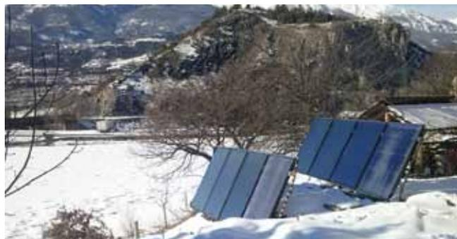
Le lieu privilégié pour l'installation des panneaux se trouve souvent ailleurs que sur le toit, l'inclinaison idéale des panneaux étant souvent plus importante que celle de ce dernier.
