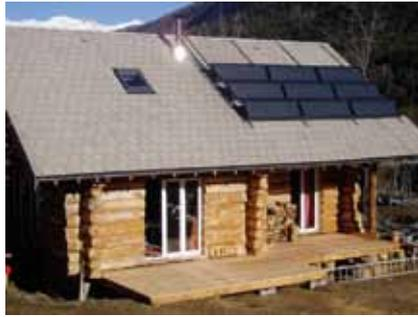
Capteurs longs inclinés à 60° pour éviter une prise au vent en toiture trop importante.
