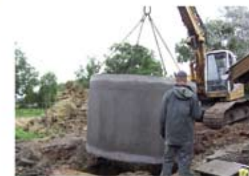
2 INSTALLATION DE LA CUVE EN BÉTON Cette dernière permet de stocker votre eau dans les meilleures conditions à température constante sans dénaturer votre environnement. Si vos aménagements extérieurs ne sont pas finalisés, profitez dès à présent d'une installation optimisée.
