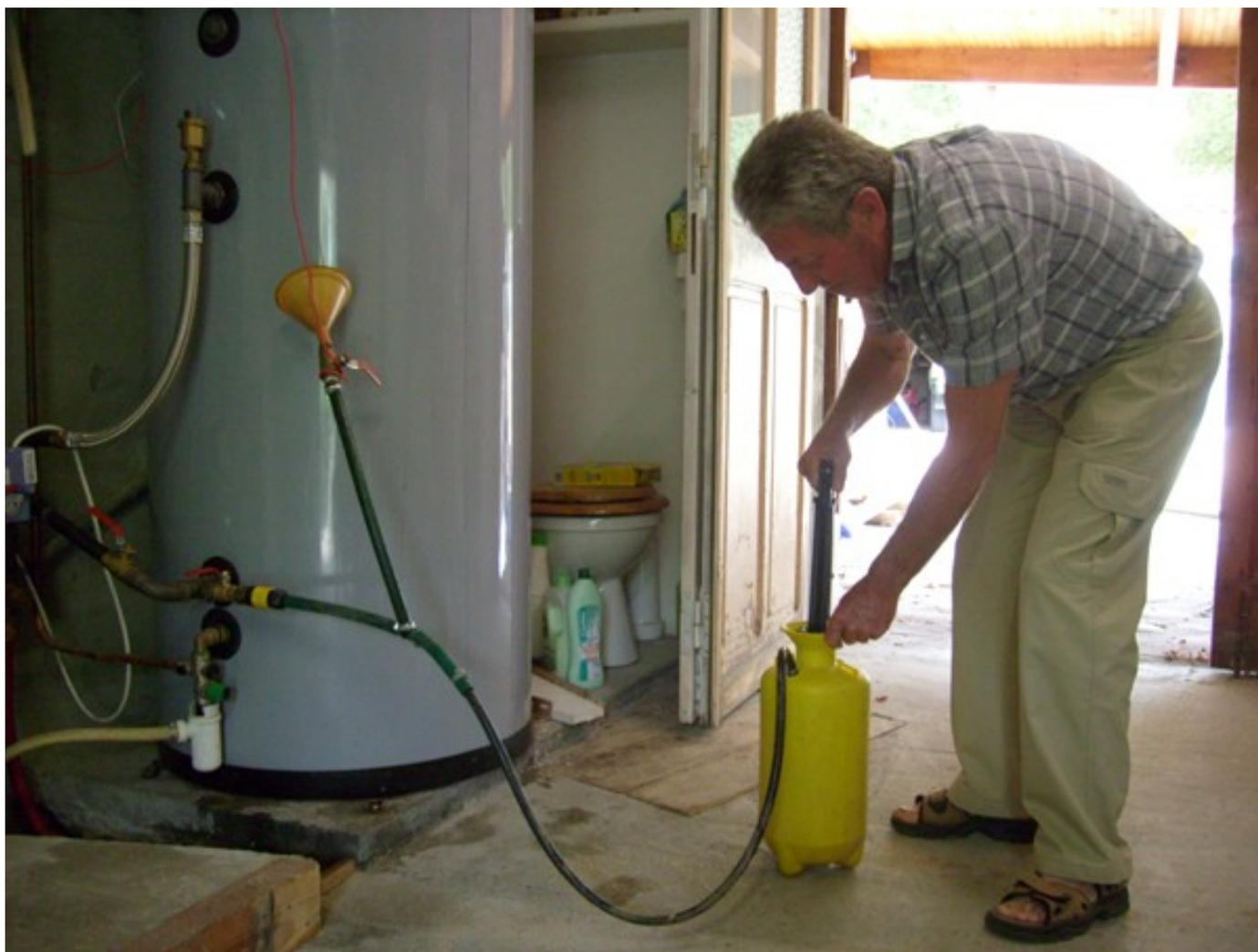
Le pulvérisateur est connecté au circuit solaire. Un entonnoir, muni d'une vanne, est connecté sur un T et permet le remplissage du pulvérisateur. Après la fermeture de la vanne, l'action sur la pompe du pulvérisateur permet de monter le circuit solaire à la pression désirée.
