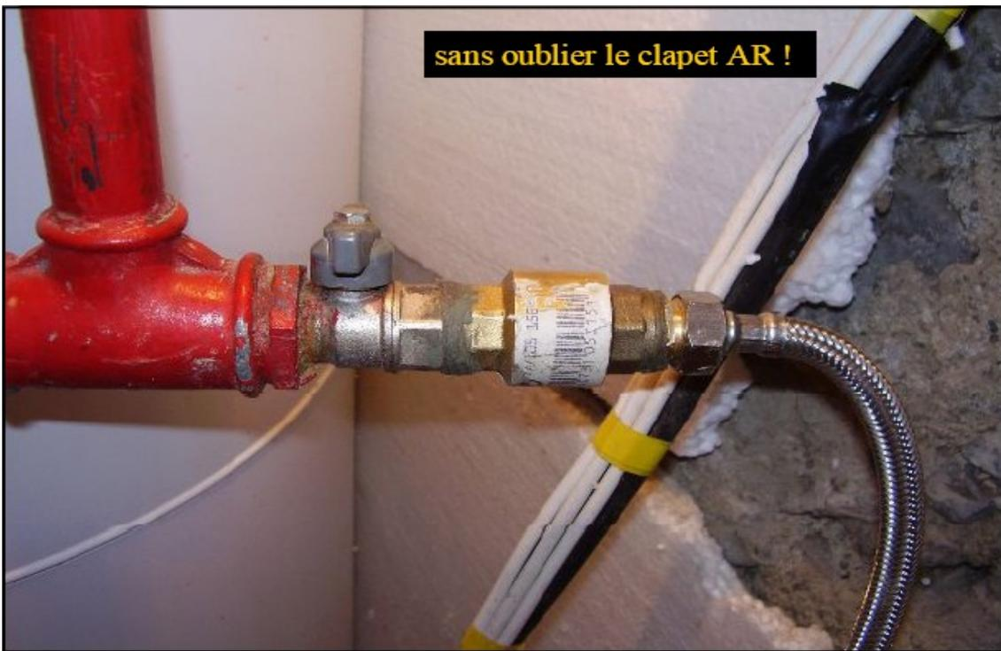
L'eau glycolée est en réserve dans un bidon. La pompe à pied est connectée sur le bouchon du bidon et met l'air qu'il contient sous pression. Le fluide est transféré au circuit solaire par un tuyau connecté en bas du bidon et donc au circuit solaire par l'intermédiaire d'un clapet anti-retour.
