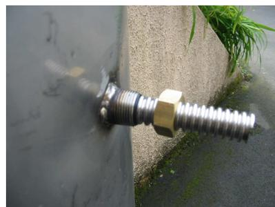
Détail sortie sur raccord fileté
