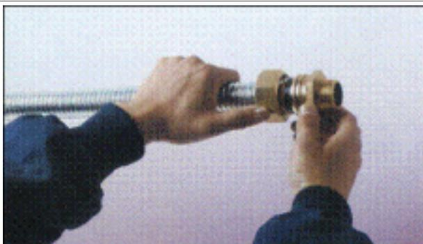
Insérer l'écrou, la bague d'arrêt et le joint graphite.
