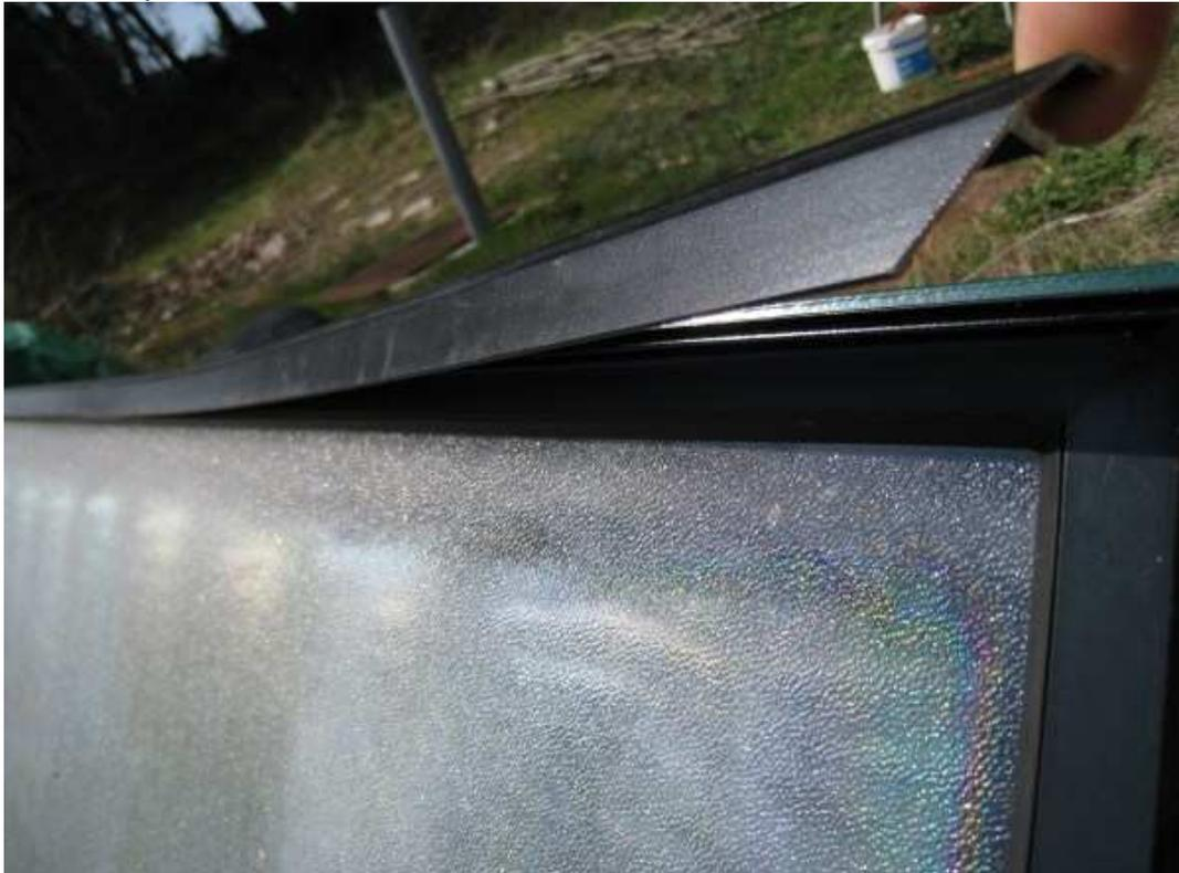
Une fois la baguette soulevée, il faut la retirer petit à petit en faisant levier avec le bord du panneau. Attention de ne pas aller trop vite, car la baguette a tendance à se courber.
