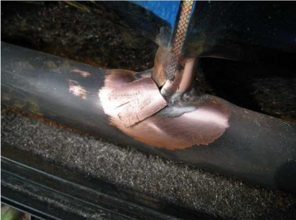
Puis découpe d'un patch en cuivre un peu plus grand que la fissure. Le patch doit être formé pour épouser la courbure du tuyau.
