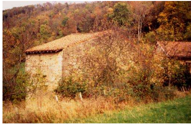
pignon sud-ouest et façade nord-ouest
