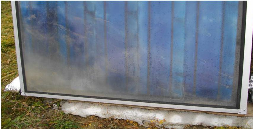
Un jour peut être je me déciderais à les démonter pour nettoyage. Je n'ai pas l'impression pour l'instant que cela handicape trop mon installation. Ils sont fixés haut et bas par des vis autoforeuses et au milieu par un gros fil de fer avec tendeur.
