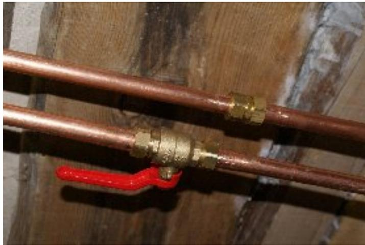
Dès le branchement terminé, j'ai mis le ballon en eau, serré des écrous et rajouté quelques joints oubliés par-ci par-là.
