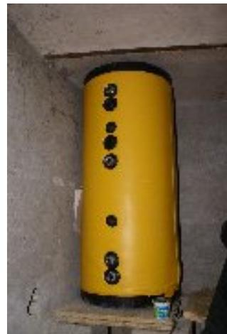
Dans la pièce derrière se trouve le ballon placé en hauteur par rapport au capteur.
