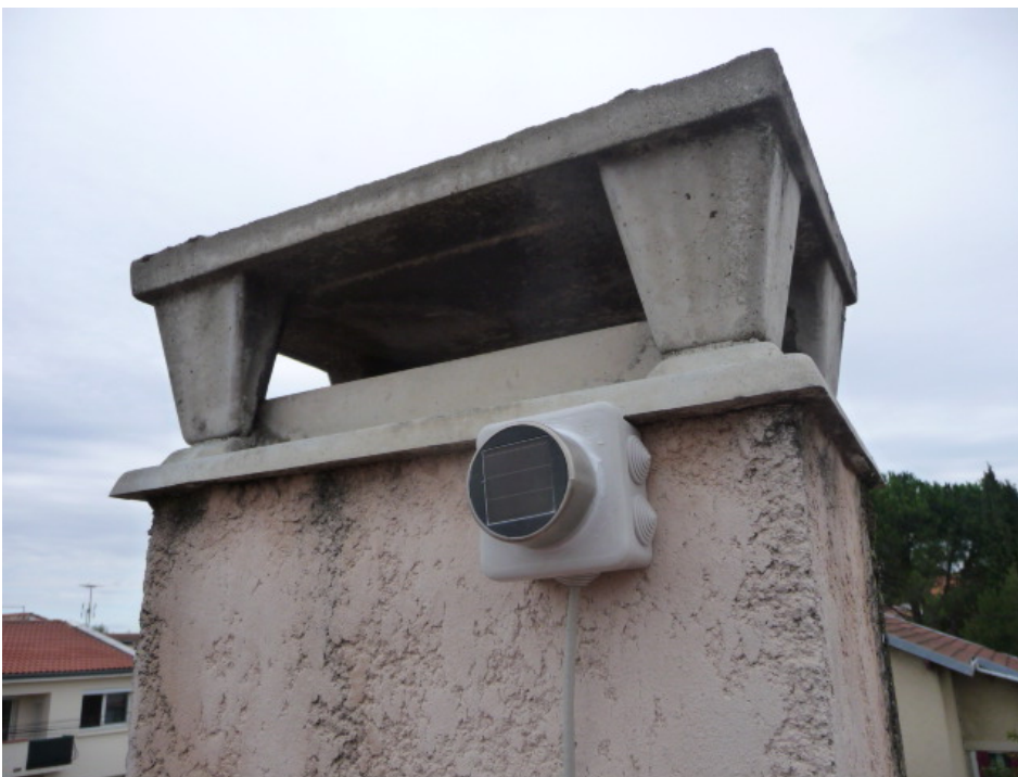
Montage finale sur la cheminé.
