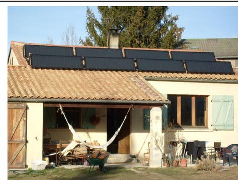
2 - Capteurs horizontaux inclinés à 60° en toiture.
