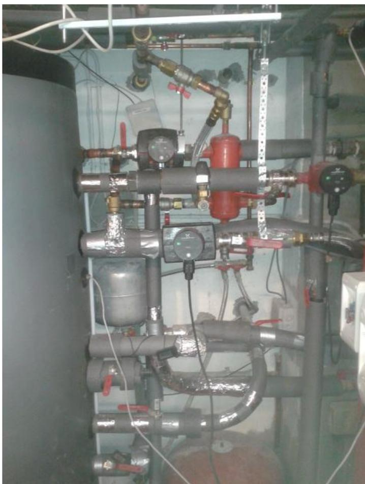
Bon OK c'est encombré. En haut, circulateur chauffage Haute température (température gestion chaudière) c'est le circuit secondaire de la bouteille. Au centre, la vanne thermostatique et circulateur basse température vers 45°C. En bas, circulateur de charge pour l'ECS rarement utilisé depuis l'arrivée de la bouteille. Le circulateur du circuit primaire de la bouteille et à l'extrême droite non visible.
